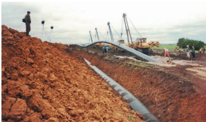
Рис. 2. Трубопровод с трубоукладчиками при реконструкции подводного перехода
