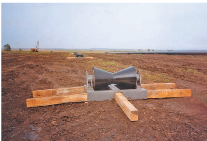
Рис. 4. Вариант конструктивного исполнения роликовой опоры
