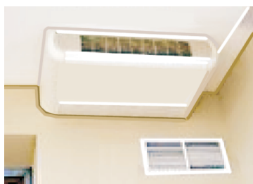
Рис. 6. Схема теплового насоса (а) и один из вариантов фанкойла (б)
