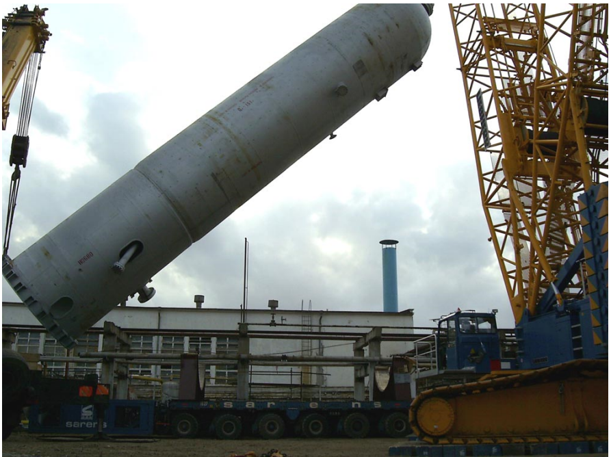
Рис. 3. Подъем реактора посредством двух гусеничных кранов
